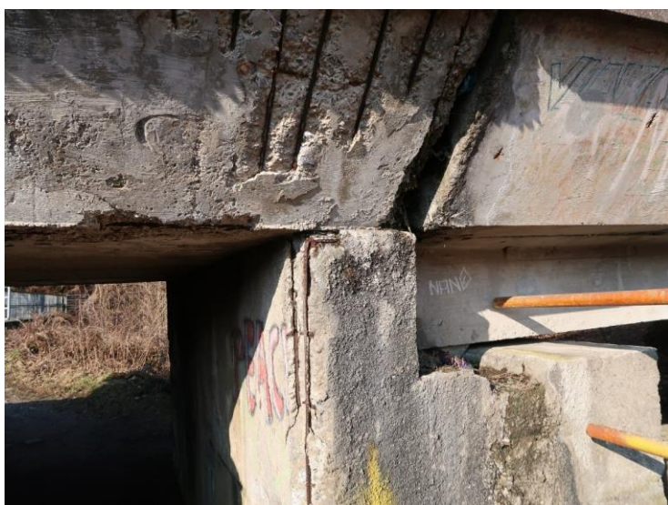
Foto č. 6 Pilíř P 01 vpravo obnažená korodující výztuž, degradovaný beton
