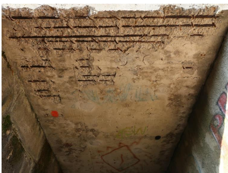
Foto č. 1 Konstrukce K 01 – podhled vpravo degradovaný beton, obnažená korodující výztuž
