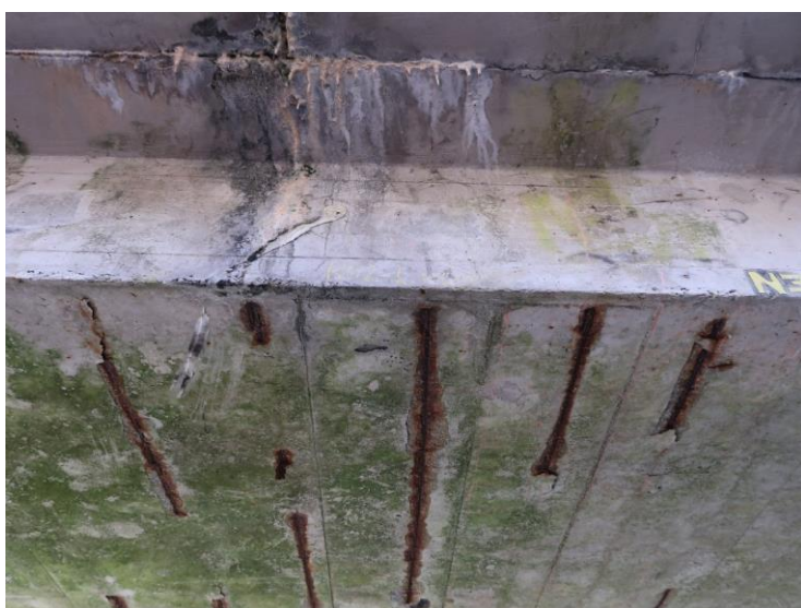
Foto č. 3 Konstrukce K 02 – podhled vlevo obnažená korodující výztuž, výluhy pojiva, průsaký vody
