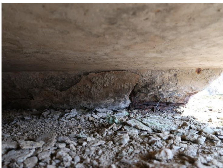
Foto č. 5 Konstrukce K 02 – uložení O 02 P degradovaný beton ozubu, korodující výztuž
