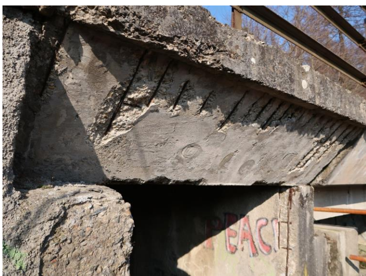
Foto č. 2 Konstrukce K 01 – zprava degradovaný beton, obnažená korodující výztuž
