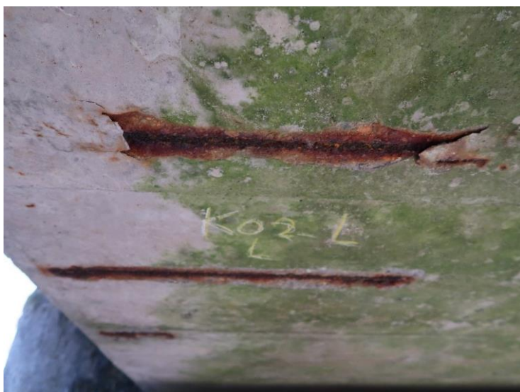
Foto č. 4 Konstrukce K 02 – levý nosník korodující výztuž
